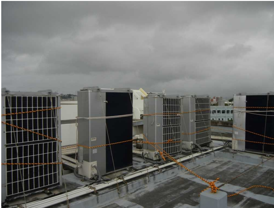
パネルの飛散防止のためロープで縛り、地面にも固定する。
