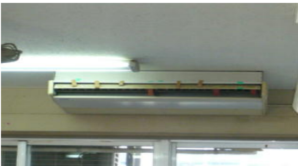
ルーバーが稼働不能のためガムテープで固定
