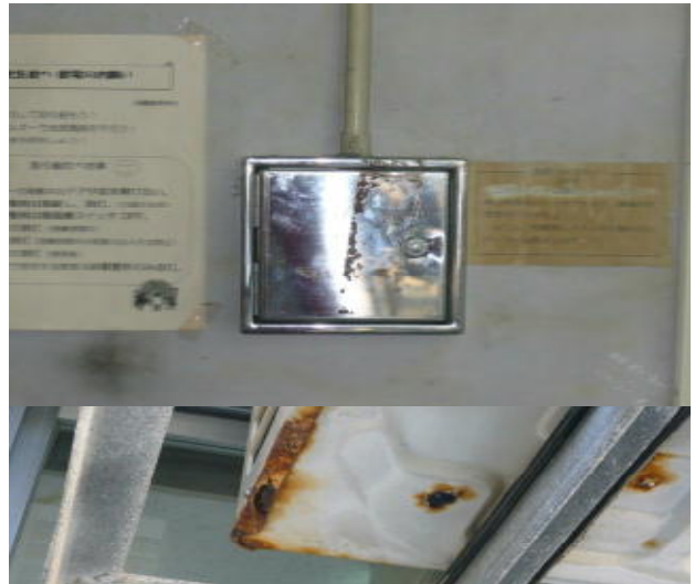
集中コントロール不能のため 各教室で空調機コントロール（同ボックス）
